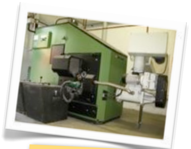
Chaudière Bavaria 100kw - rendement 90%
